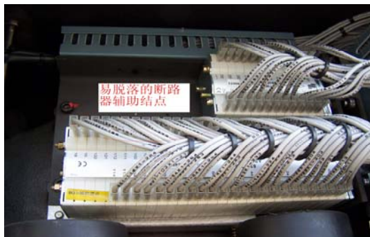
图 4 ABB 公司的 HPL 550B2 型开关辅助接点照片
